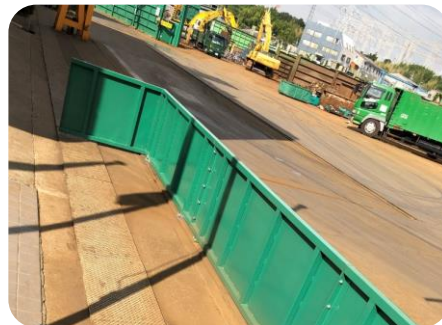
9/3 大府事務所前 飛散防止壁設置
